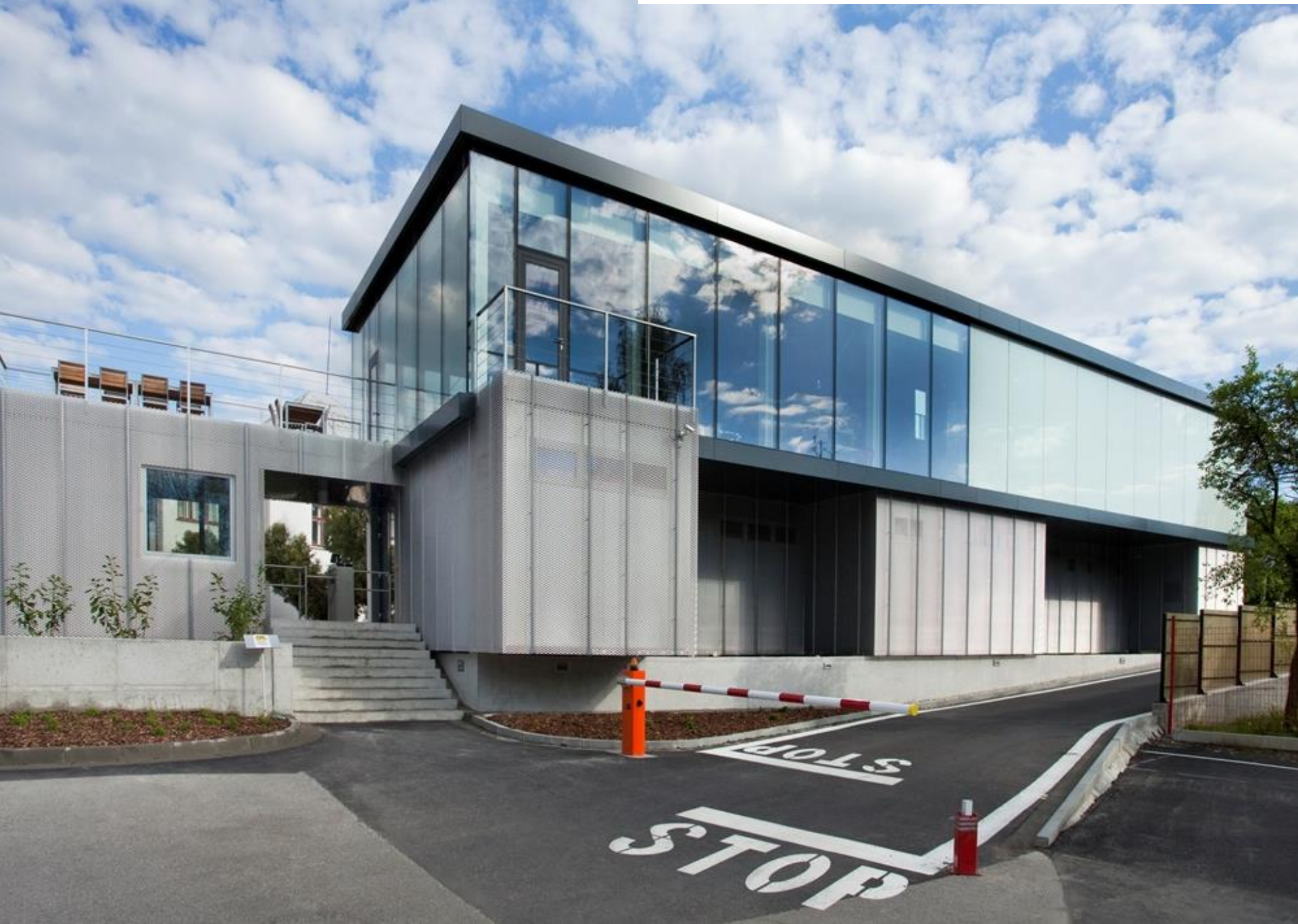
Závodní restaurace se šatnami - Vizovice
