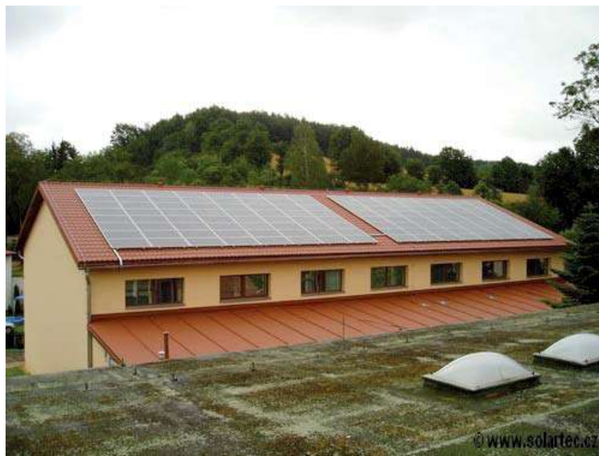
SLUNEČNÍ ELEKTRÁRNA V OBCI KNĚŽMOST na budově školy
